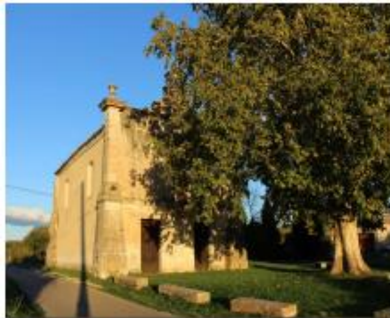
Figure 23 : Pernes-les-Fontaines- Chapelle Saint-Roch
