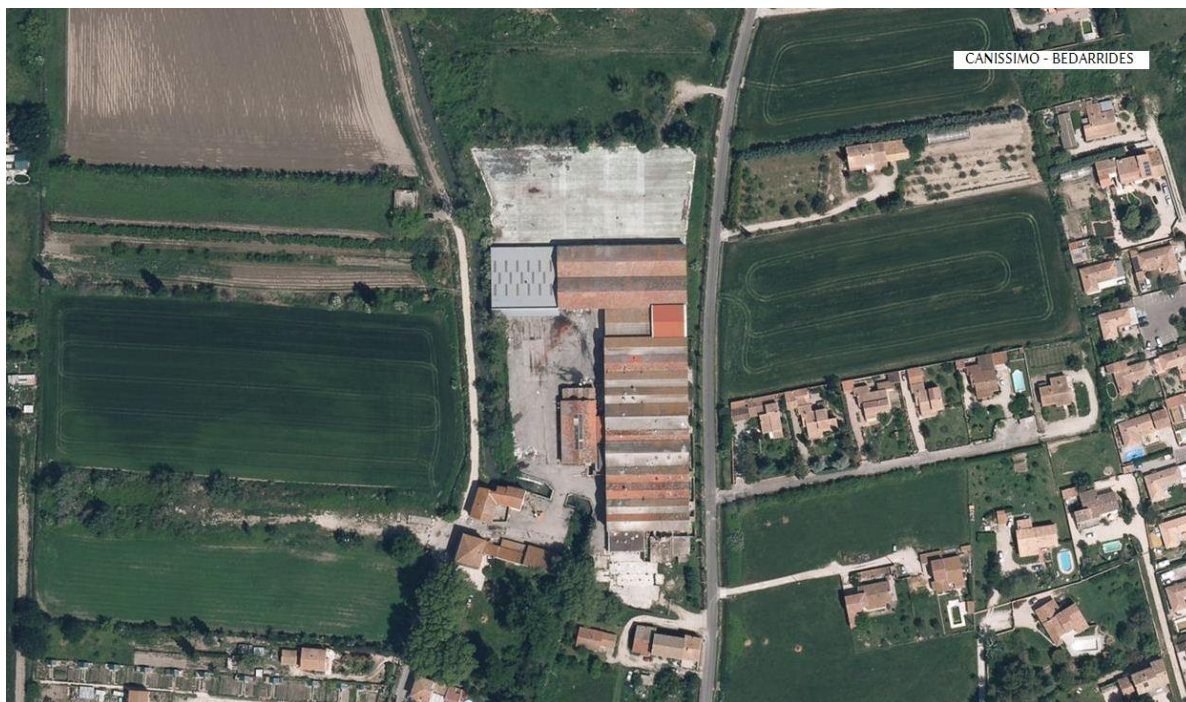
Figure 168 : Site de friche industrielle Canissimo à Bédarrides (source : BASOL)
