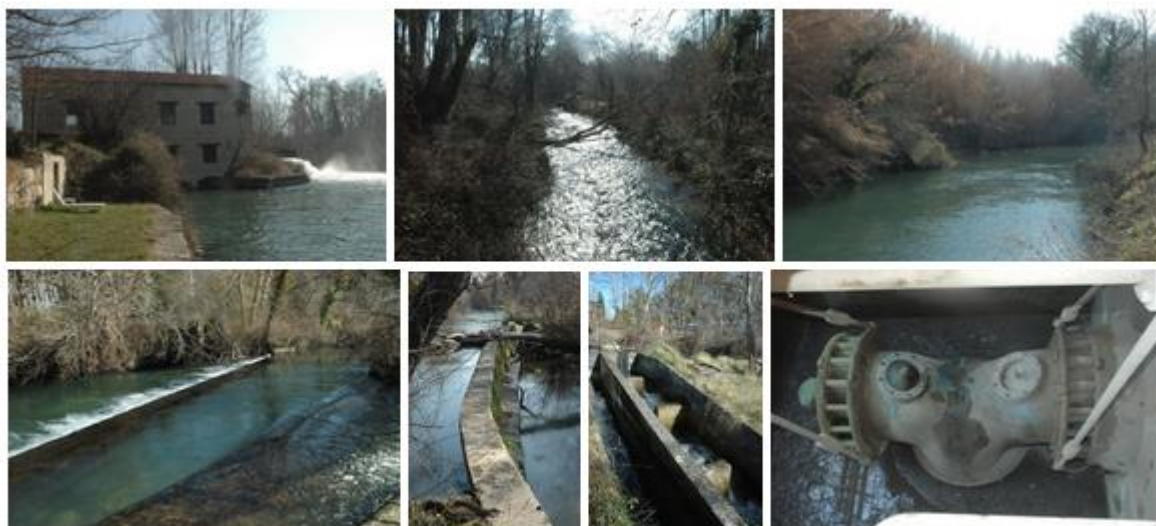
Figure 45 : Centrale hydroélectrique sur la Sorgue de Velleron à Pernes-les-Fontaines (source : http://www.eau-zone.eu/pernes_page1.php )
