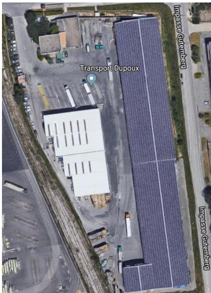
Figure 44 : Installation photovoltaïque en toiture de la société Transport Dupoux à Sorgues (source : Google Maps)
