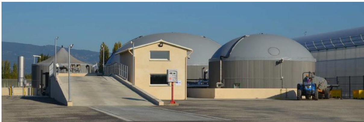
Figure 38 Tamisier Environnement (Source : VALBIO).
