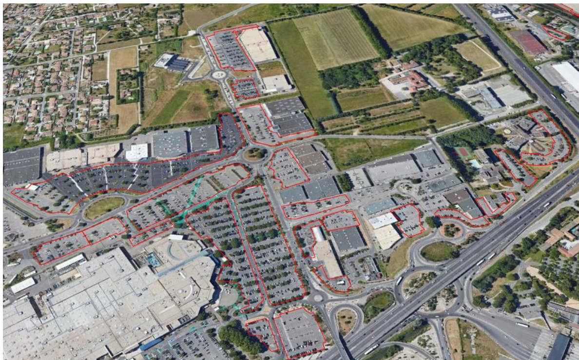
Figure 166 : Exemples de parkings pouvant accueillir des panneaux solaire PV en ombrière Parkings de la zone commerciale Avignon Nord (source : Google Earth)
